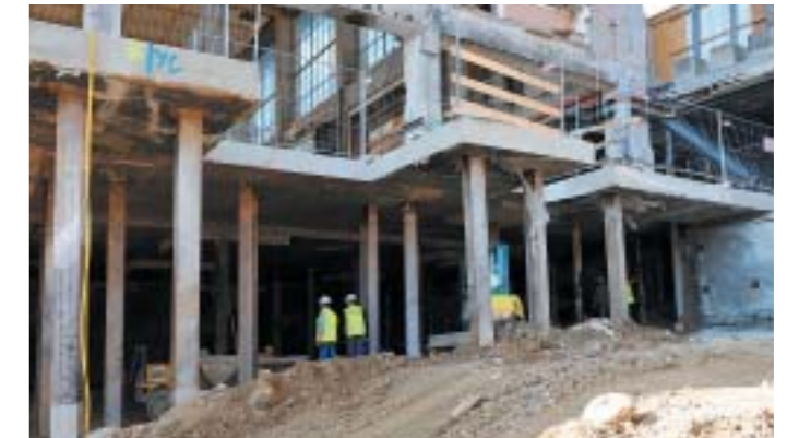
Bild 8: Unterfangung Giebelwand zum neuen Hotelgebäude, Juni 2009
