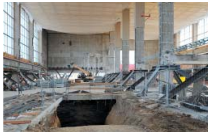
Bild 13: Abfangkonstruktion der Hauptstützen, Juli 2009
