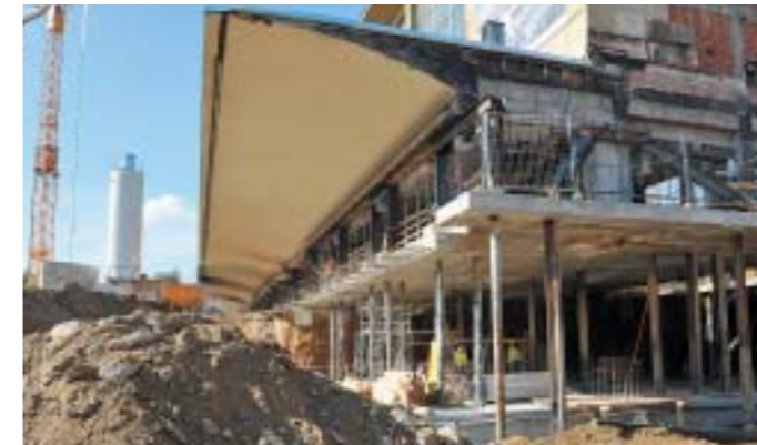
Bild 7: Fertige Bodenplatte, 1. Unterfangungsabschnitt, Juni 2009
