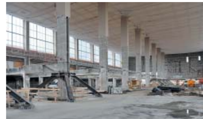
Bild 9: Detail Stahlabfangung Hauptstütze, fertiger Betondeckel, Juni 2009
