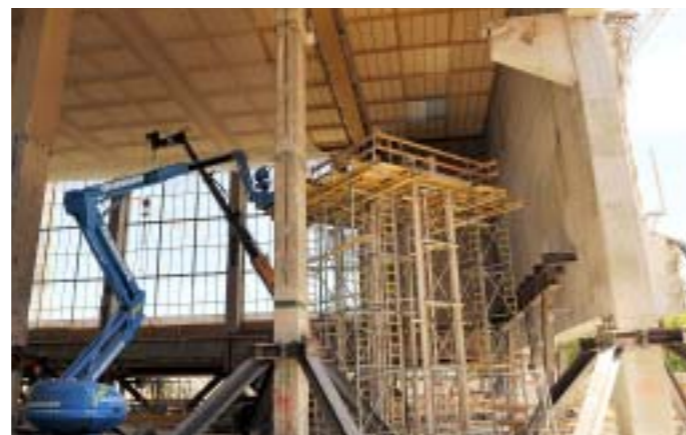
Bild 15: Abfangkonstruktion der Giebelwand (südlich, U-Bahn), Juli 2009
