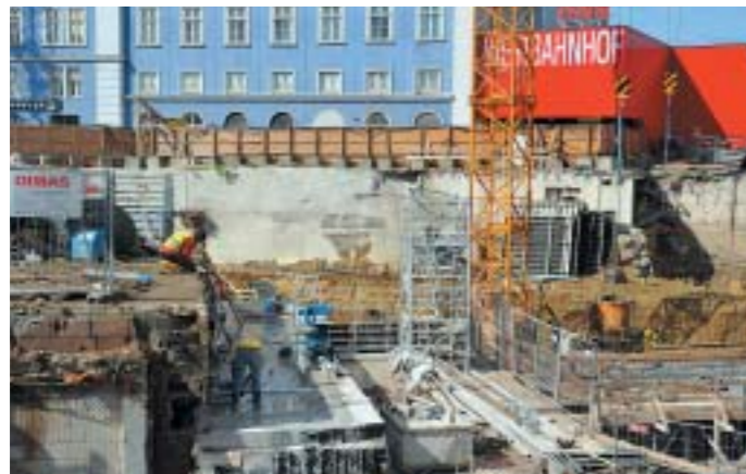
Bild 12: Betonschneidearbeiten im Bereich Zugang Wiener Linien (U3-Station), Juli 2009
