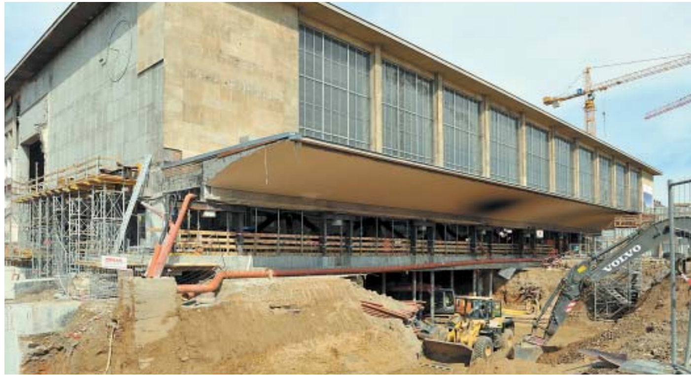
Bild 11: Erdaushub im Bereich Europaplatz, Juli 2009
