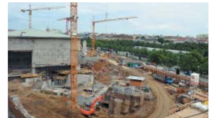
Bild 10: Erdaushub im Bereich Zugang Wiener Linien (U3-Station), Juni 2009
