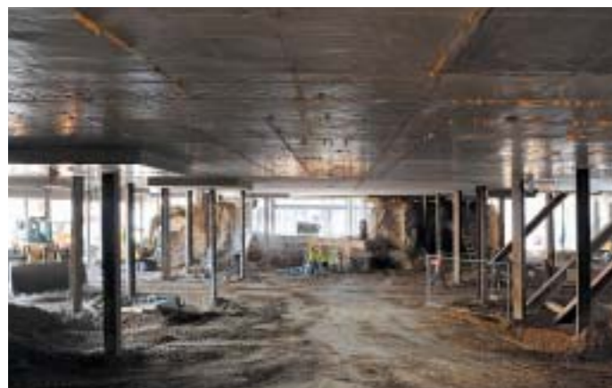
Bild 14: Unterfangungsarbeiten (Deckelbauweise) Zugang Wiener Linien, Juli 2009
