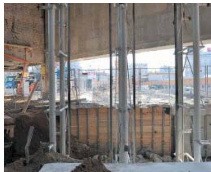
Bild 1: DSV-Körperherstellung Zugang Wiener Linien (Bereich ehemaliger Lift und Fahrtreppen), April 2009
