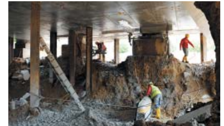
Bild 4: Durchschneiden der bestehenden Fundamente der Hauptstützen unter dem Deckel, Mai 2009
