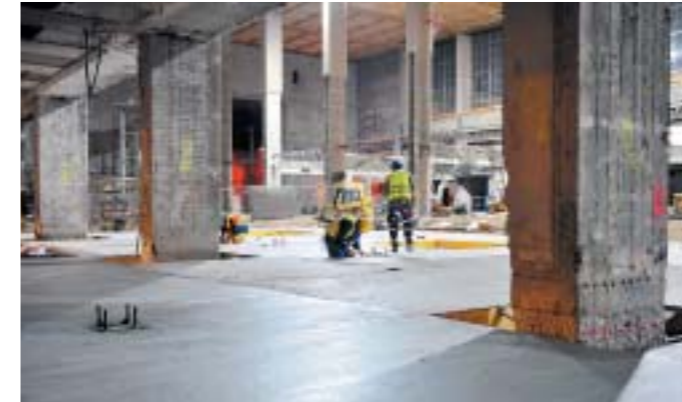
Bild 5: Betondeckel, Vorbereitung für die Abfangkonstruktion, Mai 2009
