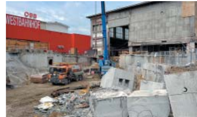
Bild 3: Betonschneidearbeiten im Bereich Zugang Wiener Linien (U3-Station), Mai 2009
