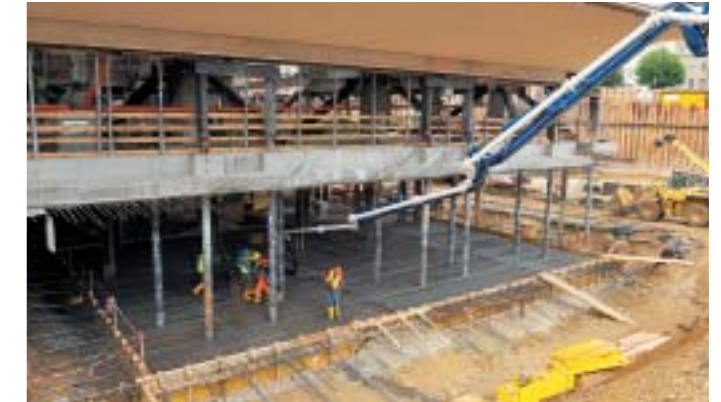
Bild 6: Betonieren der Bodenplatte (1. Abschnitt), Mai 2009
