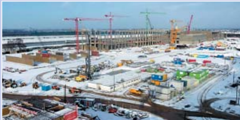
Bild 8: Übersicht der Baustelle im Winter 2008/09
