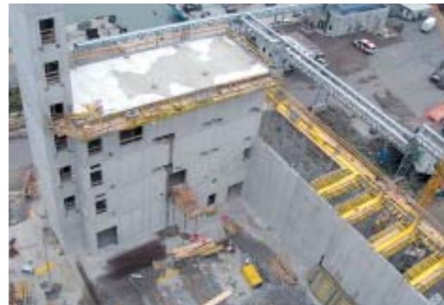
Bild 7: E-Räume mit Brenngasgebläseraum
