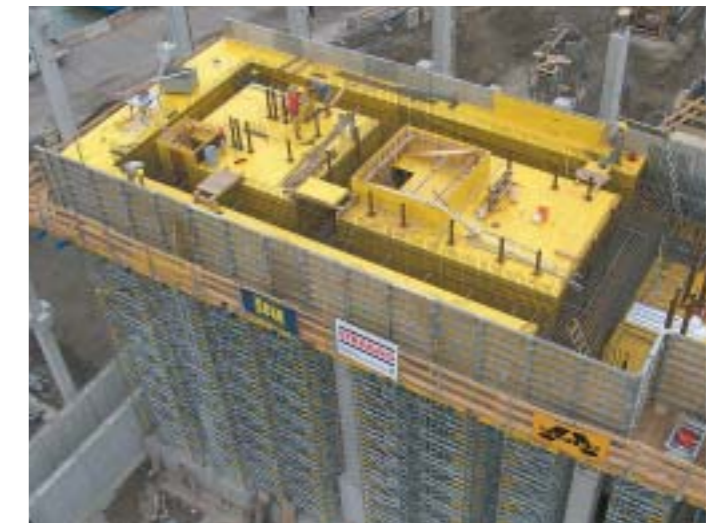
Bild 12: Turbinentisch-Schalung
