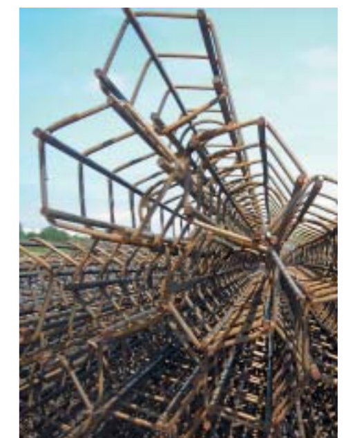
Bild 3: Geschweißte Pfahlkörbe
