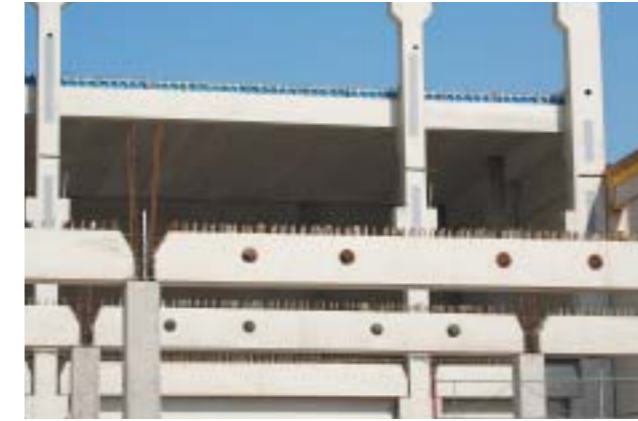
Bild 9: Halffertigteile im Zwischentrakt
