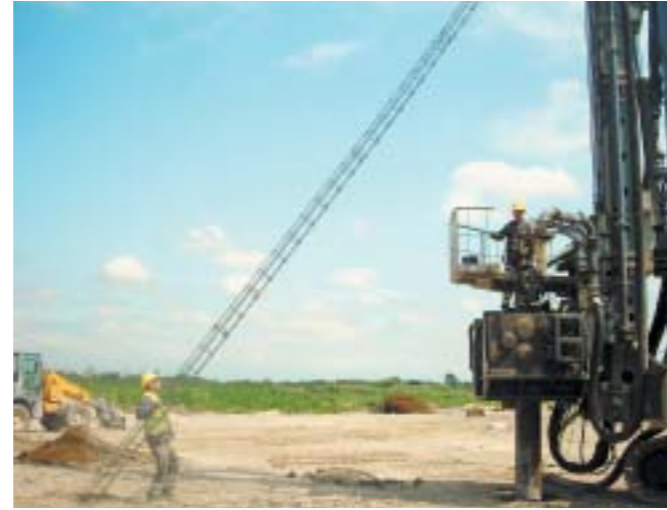
Bild 5: Einbau der Pfahlkörbe
