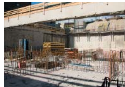
Bild 2a+b: Aussteifungsrost Schlitzwand Pumpenzentrale
