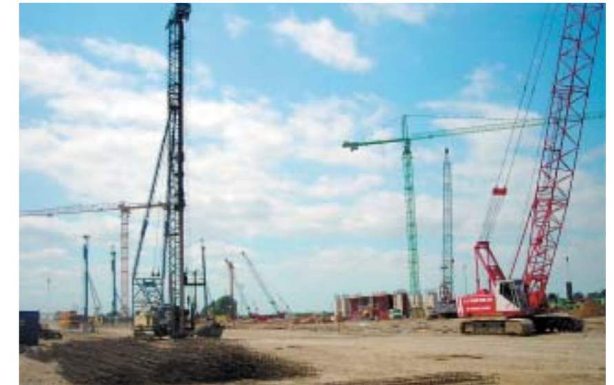
Bild 1: Bis zu 6 Spezialtiefbaugeräte gleichzeitig im Einsatz
