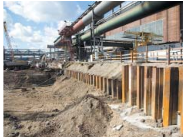
Bild 3: Spundwand im Bereich Zwischenbau u. Maschinenhaus
