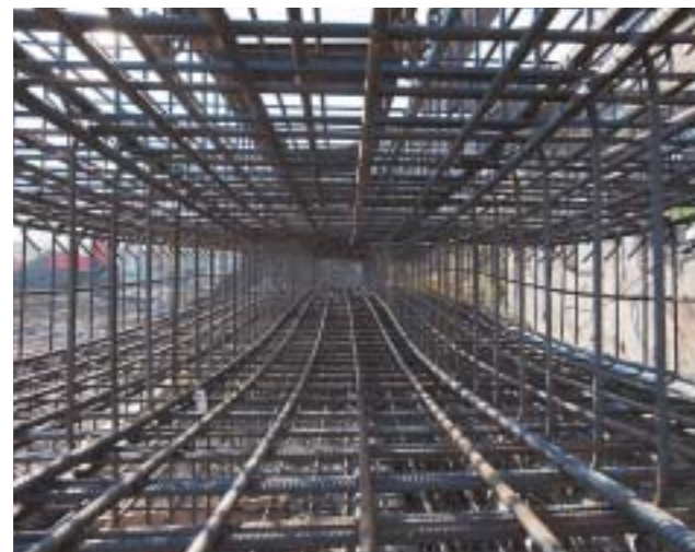
Bild 5: Schlitzwandbewehrungskorb
