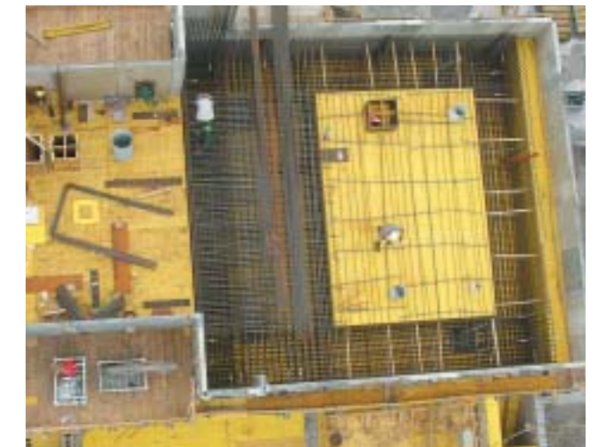
Bild 13: Bewehrung Turbinentisch
