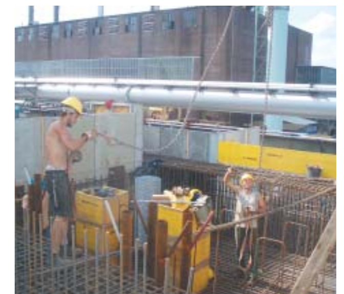
Bild 14: Turbinentisch-Bewehrung und Einbauteile
