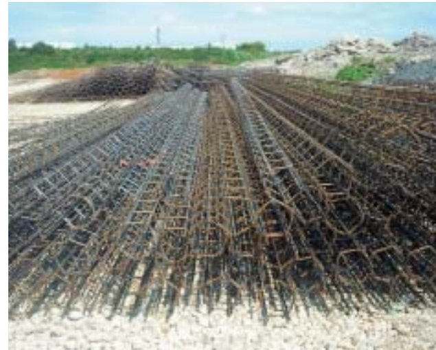
Bild 4: Lagerplatz Pfahlkörbe
