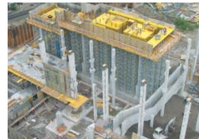
Bild 11: Rüstung freistehender Turbinentisch
