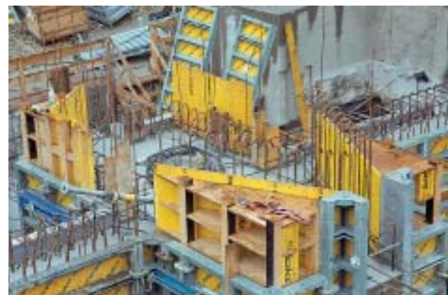
Bild 17: Schalung Pumpenkammern
