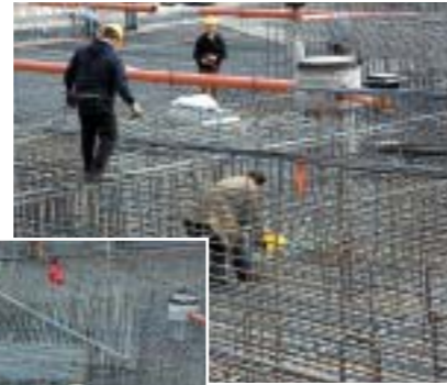
Bild 6: Bewehrung Kesselhausbodenplatte
