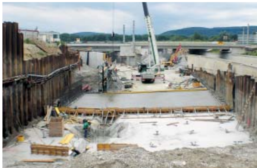
Bild 3: Herstellen des Tunnelvorportals Bereichs Rampe 200 (Abfahrtsrampe RFB Stockerau)
