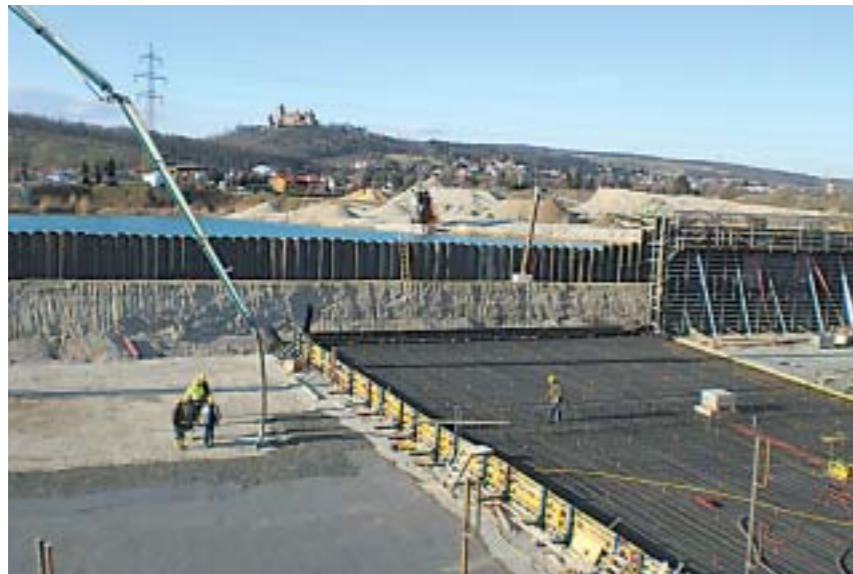
Bild 6: Regelblock neben Schotterteich – Arbeiten 3,0 - 4,0m unter GW-Niveau
