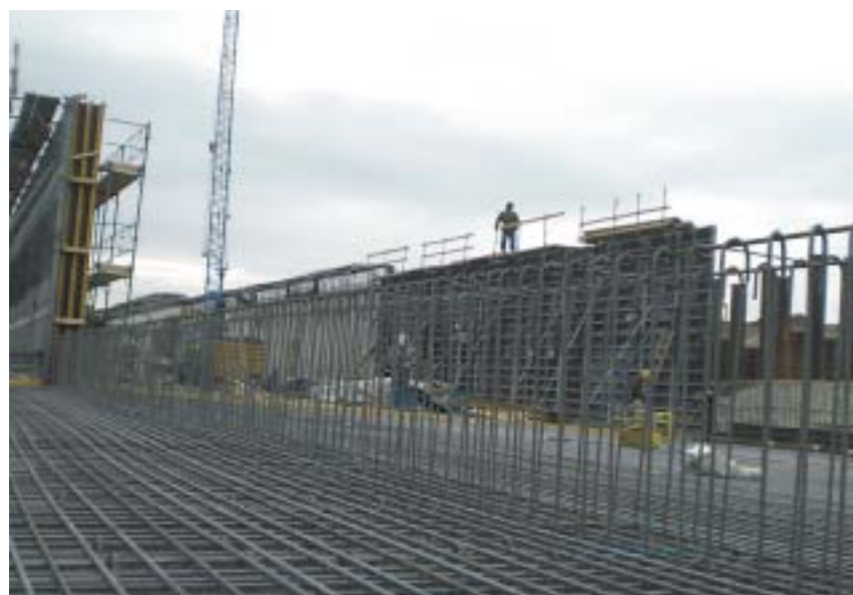
Bild 7: Bodenplatte + Wände im Regelbereich
