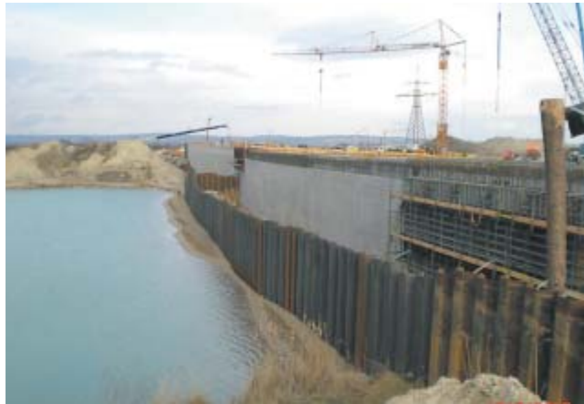
Bild 5: GW-Situation neben Baugrubensicherung Umweltschutz
