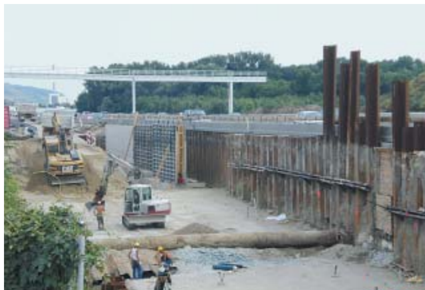
Bild 4: Herstellen der ersten Wannenblöcke auf der gesperrten Rampe 200 – Anbindung an A22
