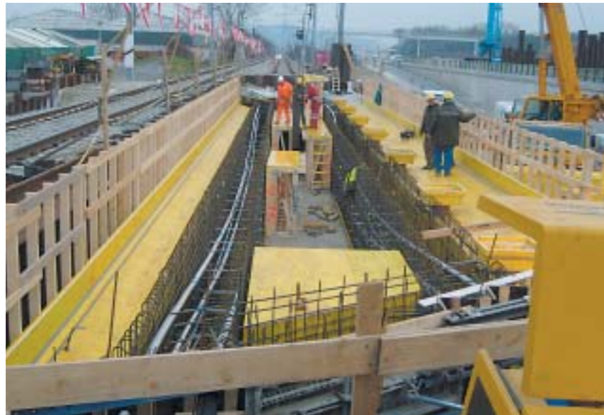
Bild 2: Überbauschalung mit Spannkabel ÖBB-Brücke, Tragwerk Gleis 2. Arbeiten neben 1-gleisigem ÖBB-Betrieb!
