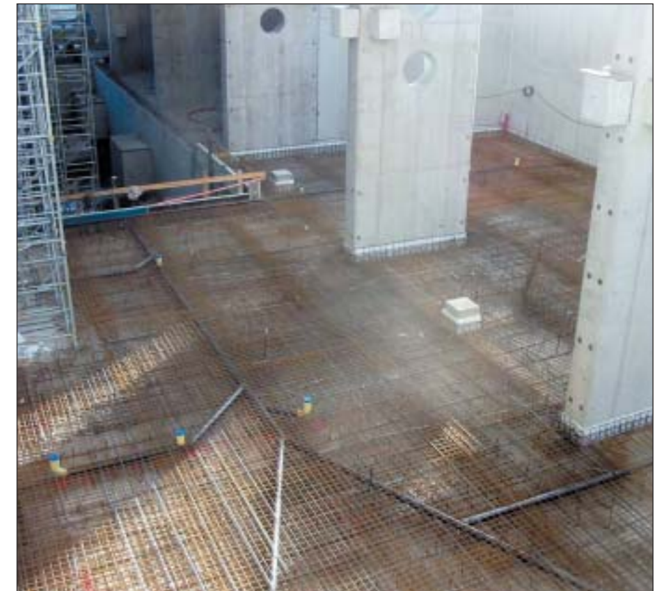
Bild 6: Bodenplatte Kondensat Maschinenhaus
