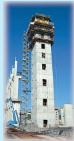
Titelbild: Ansicht Fluchttreppenhaus
