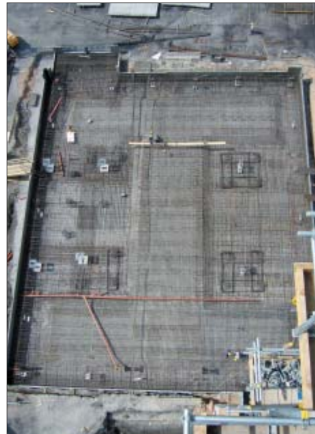
Bild 4: Bodenplatte Trafo block
