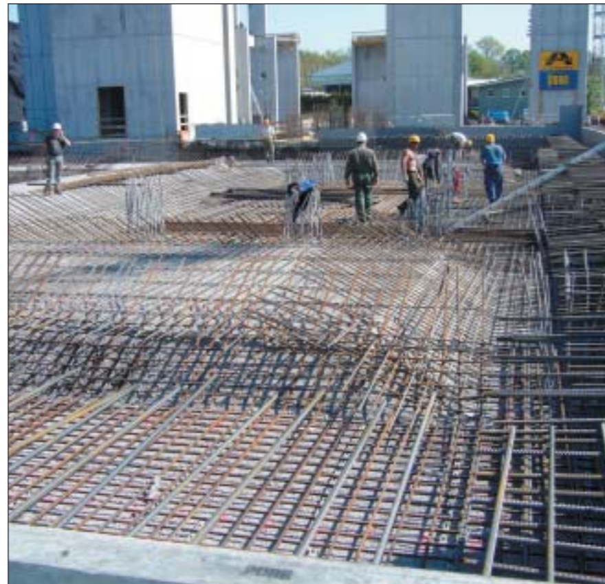
Bild 5: Fundamentplatte Kesselhaus
